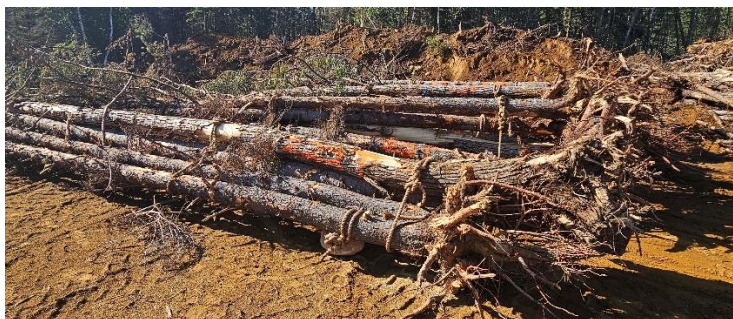
Embâcles de bois prêtes à être installées
