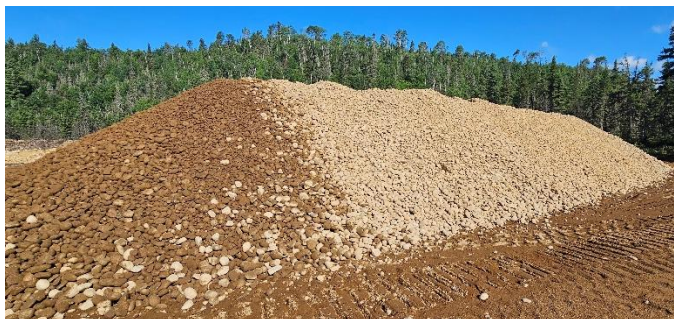
Pile de matériel prêt à être utilisé pour la mise en place des recharges sédimentaires
